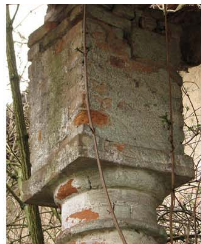
Fig. 5 - Porzione di fabbrica a sud dell'aia e particolare del capitello di una delle due colonne in laterizio
