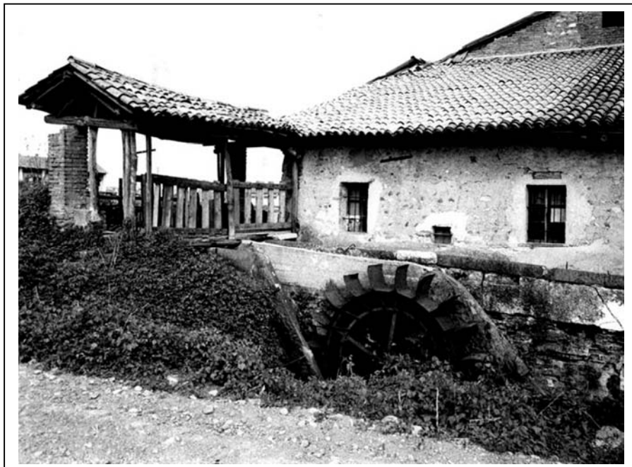
Fig. 1 - Non più esistente il passaggio coperto sul fosso che garantiva l'alimentazione d'acqua sulla ruota che, allo stato di fatto, risulta rimossa dallo scivolo. Foto d'archivio fornita dalla Civica Biblioteca del comune di Cazzago San Martino.
