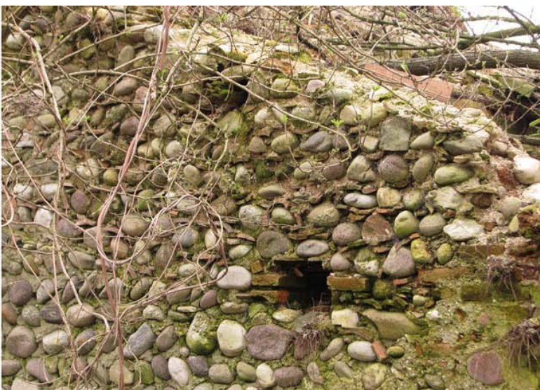
Fig. 4 - Corpo di fabbrica principale: viste parziali della muratura est: da notare la "passeraia" a muro
