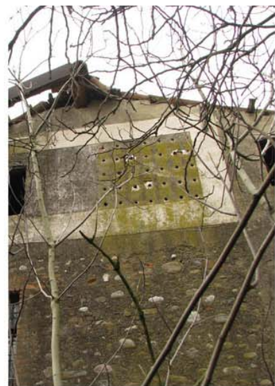
Fig. 4 - Corpo di fabbrica principale: viste parziali della muratura est: da notare la "passeraia" a muro
